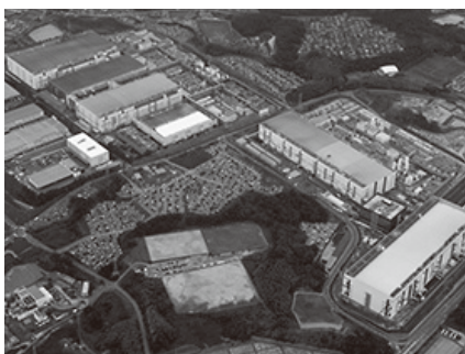
四日市工場(右下の建物が第6製造棟)
